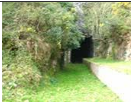
El túnel de la Viona
